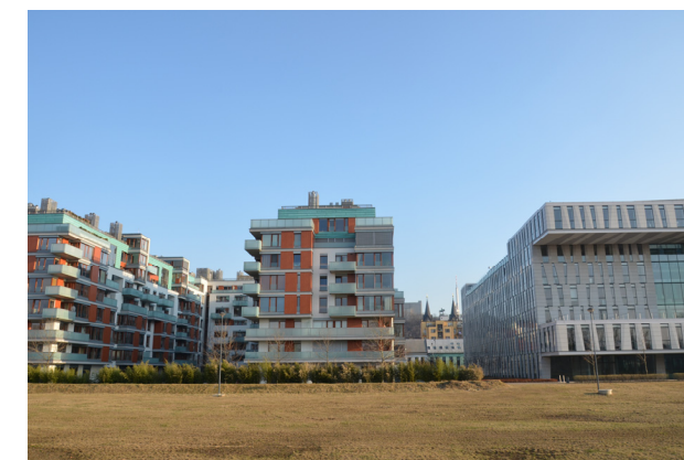
Výstavba komplexu River city Karlín, 2012
